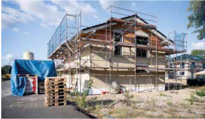
Wenn der Einzugstermin wegen Verzögerungen auf der Baustelle ins Wanken gerät, können Zusatzkosten drohen. (Foto: DJD/Bauherren-Schutzbund/Florian Schuh)
