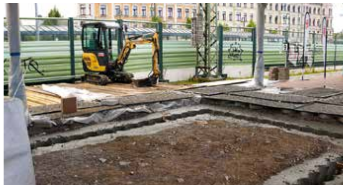
Baustart am neuen Aufzug für den Bahnhof Markranstädt
