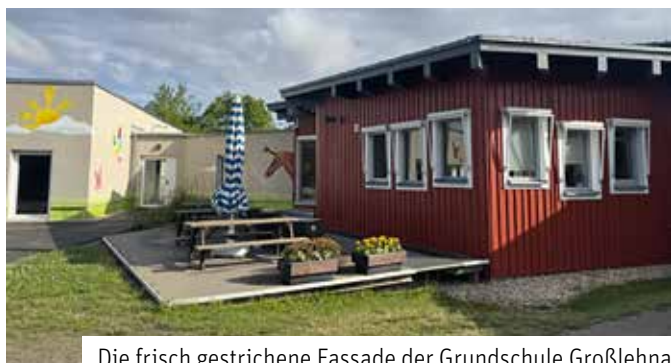
Die frisch gestrichene Fassade der Grundschule Großlehna
