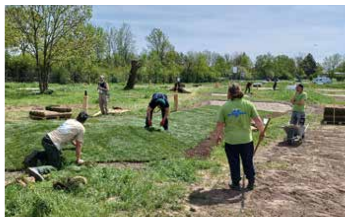
Anfang Mai wurden ca. 2.000 Quadratmeter Rollrasen verlegt, der bis zur Eröffnung festwurzeln muss. (Foto: EGW/Bernd Walther)
